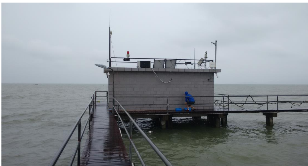
Abbildung 3: Bootshaus am Jetty / Ort für Monitoring und Sampling (eigenes Foto)
